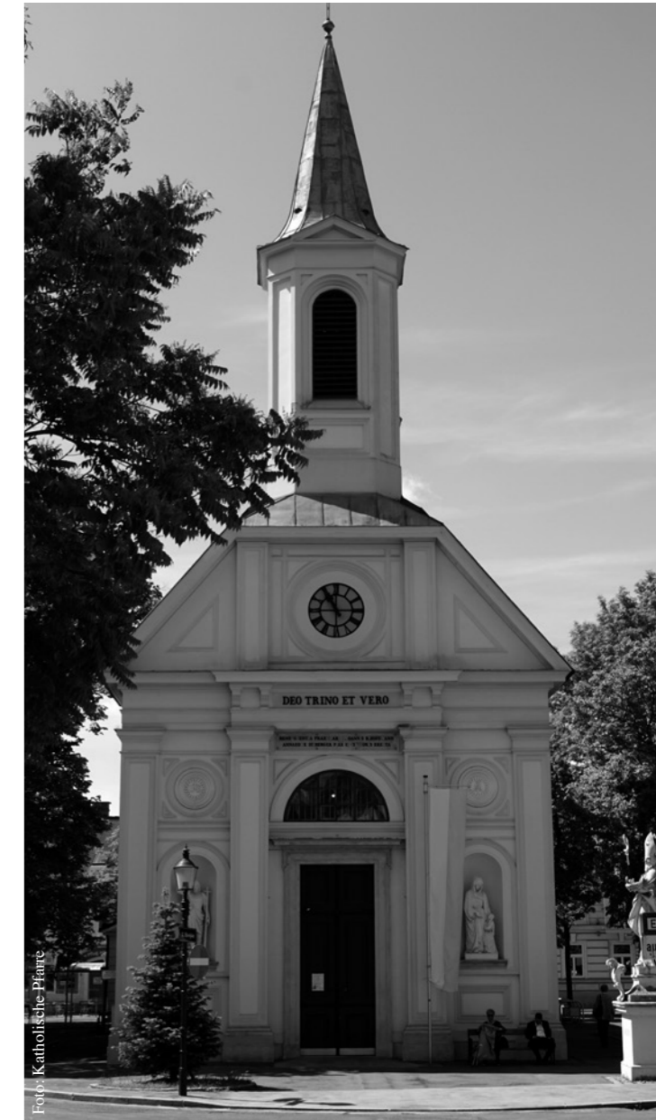
Das Portal der Kirche am Khlesplatz
